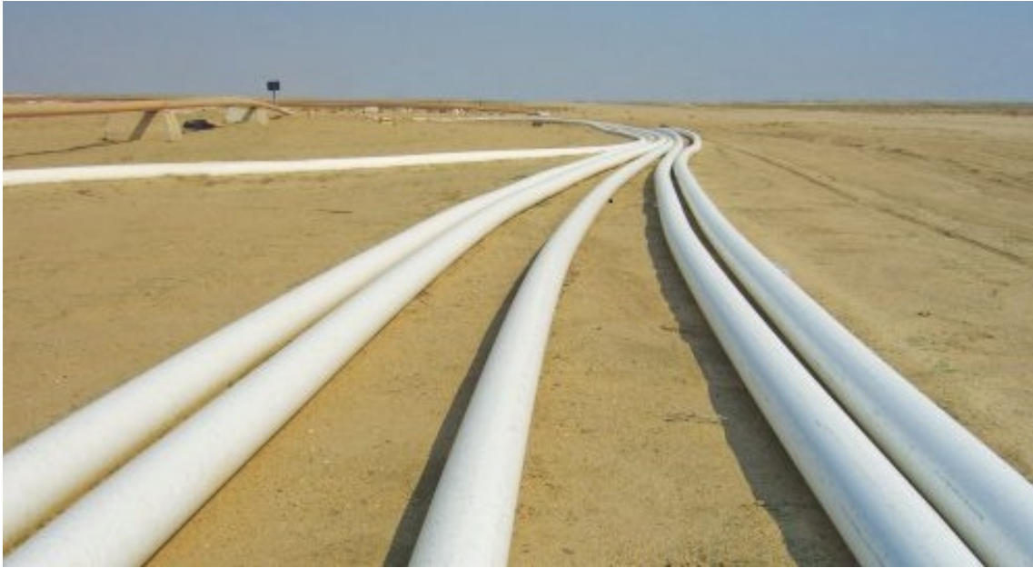
Figura 2.7: Mangueiras com hidrocarbonetos em solo
