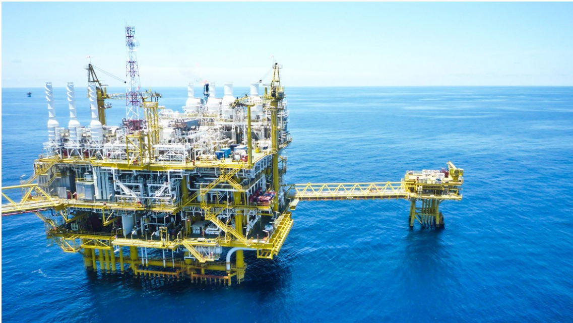
Figura 2.5: Plataforma de petróleo e gás off-shore
